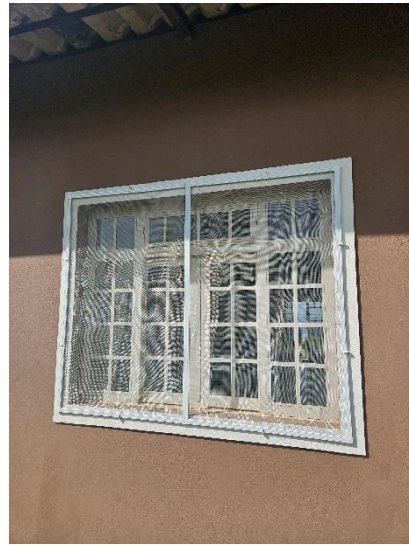
Depois - Janela com tela instalada Autoria: Carolina Rodrigues Bordignon Data:29/11/2023
