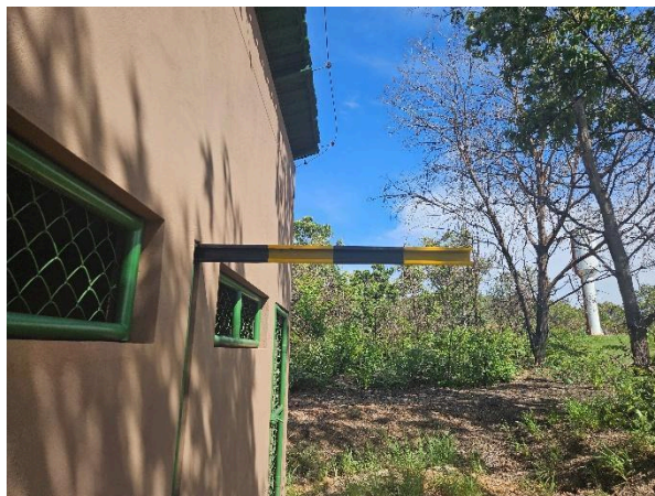
Sinalização em barra de ferro Autoria: Carolina Rodrigues Bordignon Data:29/11/2023
