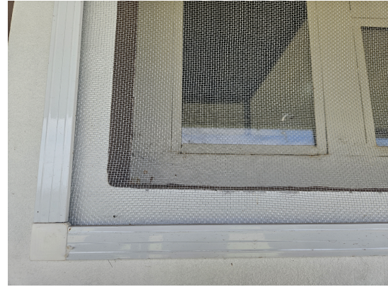
Depois - Telas metálicas Autoria: Carolina Rodrigues Bordignon Data:29/11/2023
