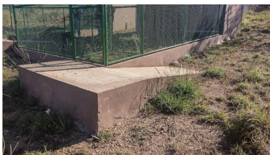
Rampas de acesso Autoria: Carolina Rodrigues Bordignon Data:27/06/2023
